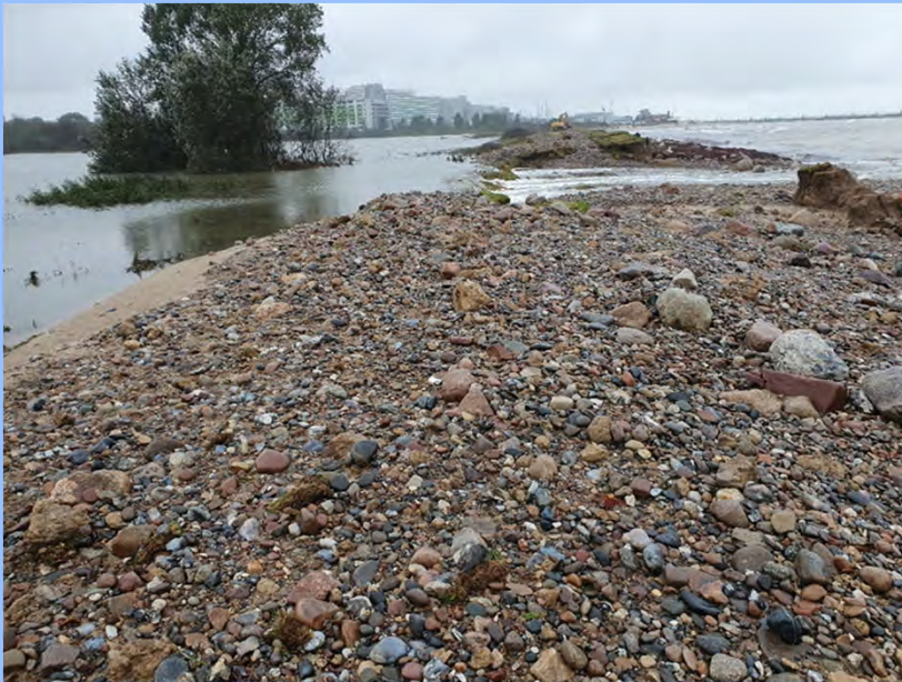
Deichbruch Damp (Fischleger) (21.10.23)
