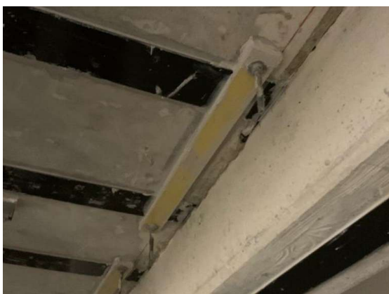
Stahlflasche mech. verankert bei Decken
