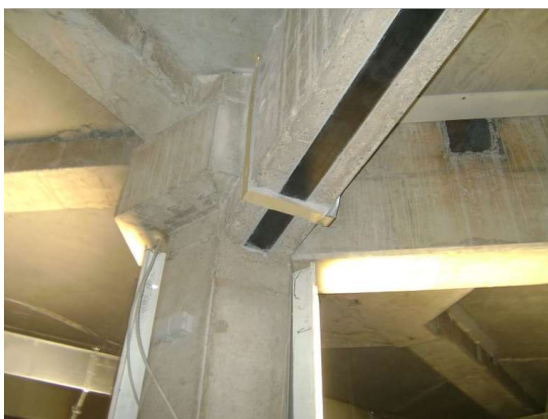
Bügelumschließung bei Unterzügen
