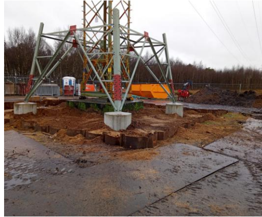
Verfüllte Baugrube mit Spundwand
