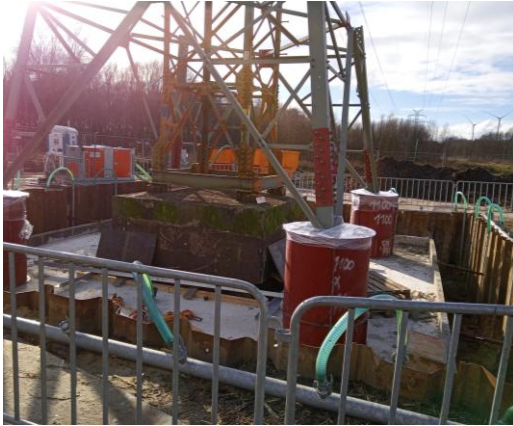
Gründung umfasst Bestandsfundament
