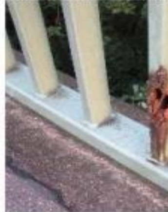
FÜLLSTAB DURCHGEROSTET
