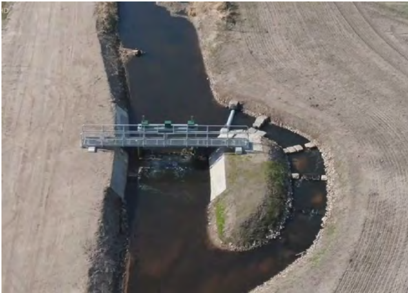
Bild 1: Stauanlage in der Tanger, Sachsen-Anhalt (Quelle: mdr)
