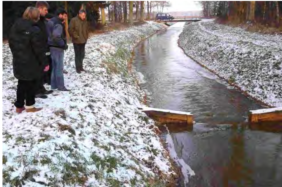
Bild 2: Stauanlage Beispiel aus der Lucie, Wendland (Quelle: Dachverband Feldberegung)
