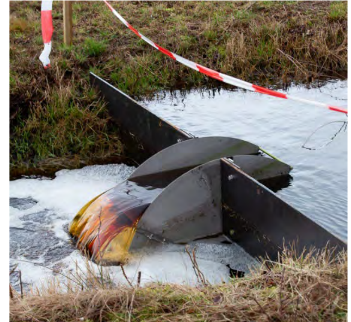
Bild 4: Suderburger Stauklappe (Gnarrenburger Moor, © Ostfalia/INBW)
