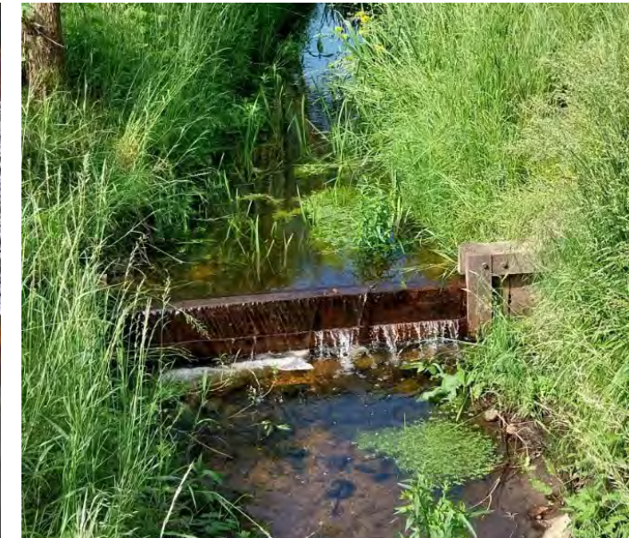
Bild 3: Stauanlage in der Wipperau, Uelzen
